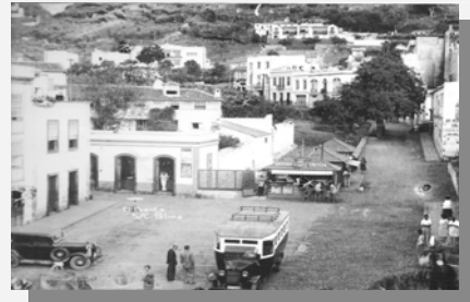
Avenida El Puente
